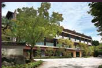
南館エントランス
